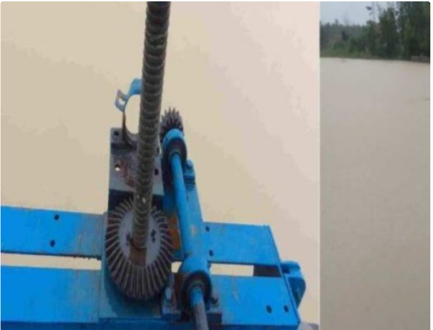
Pintu air Albaret Simpang Mesuji
